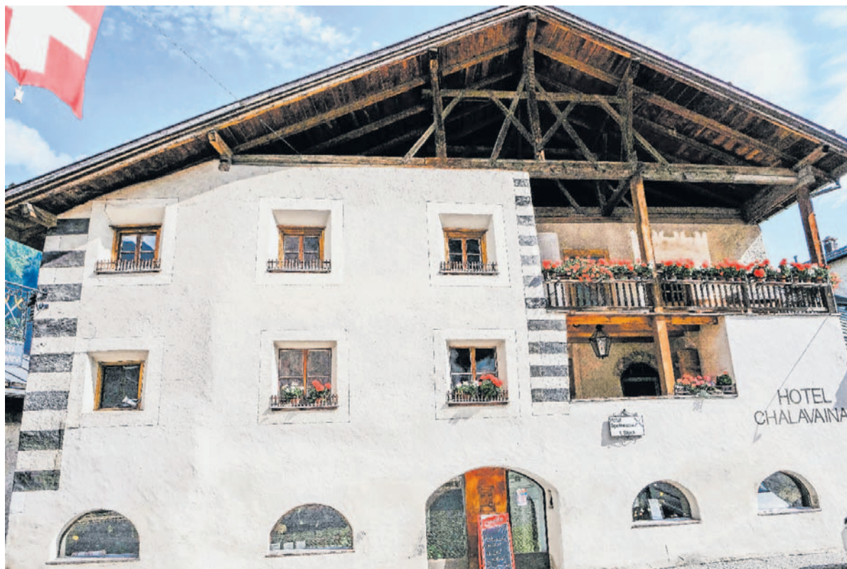
Daspö il 2022 ha l'hotel da tradiziun sül Plaz Grond a Müstair novs gestiunaris.
